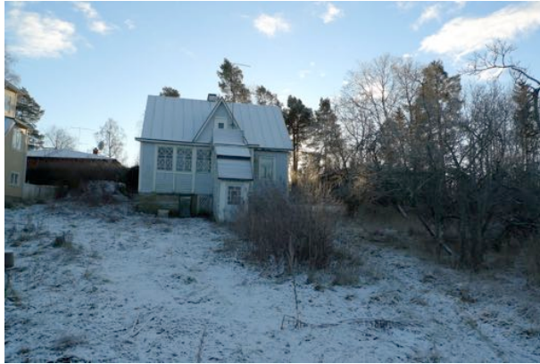
Shamaletdinin rakennus pohjoisesta katsottuna. Vas. kolme ikkunaa kuuluvat verantaan, jonka myöhempi asukas on pääosin muuttanut saunatiloiksi 1980-luvulla.
