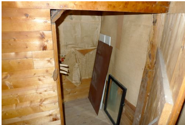
Ullakkotilojen varastotilaa. Ajan tyylin mukaisesti sijoitettiin kattolaipioiden alle.
