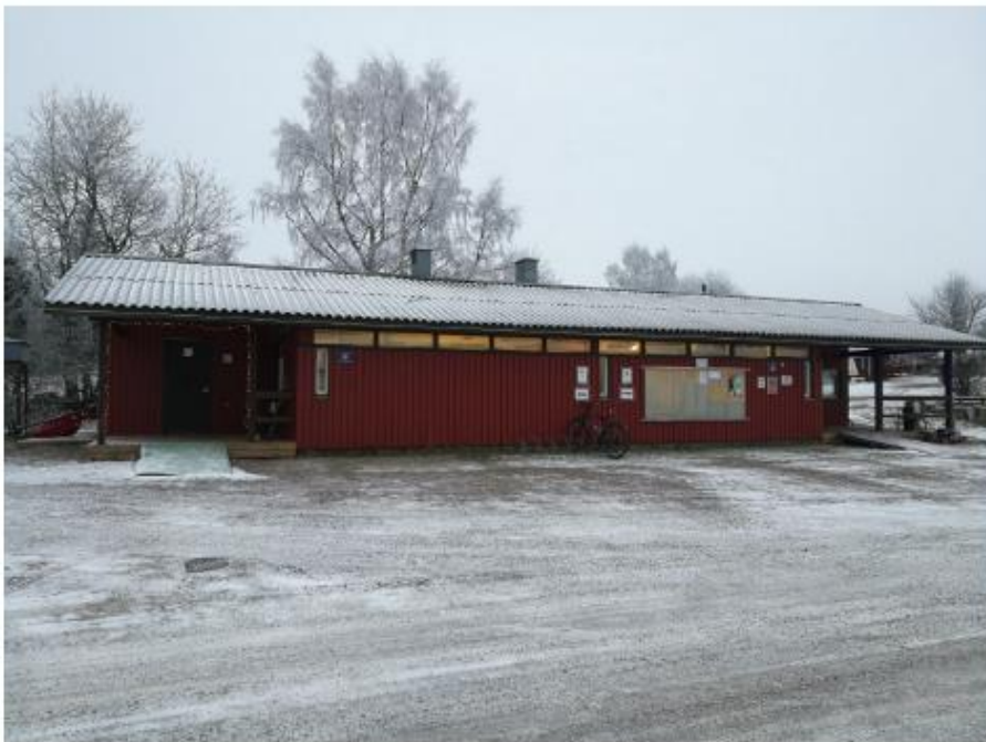
Eero Lötjönen 11.01.2018 12:30 4. Huoltorakennus
